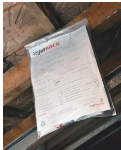
Exemple : traçabilité pour une isolation de combles perdus (isolant laine de roche JetRock)
