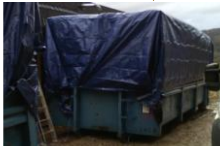
Stockage sur chantier dans les bennes céréalières bâchées utilisées pour la livraison
