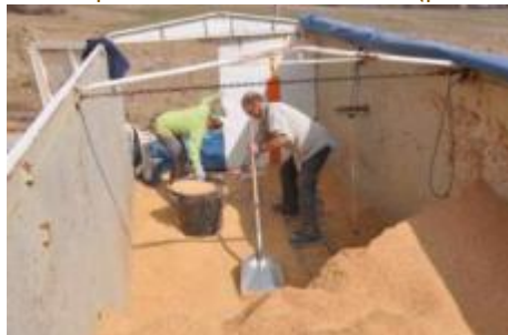
Stockage sur chantier dans les bennes céréalières bâchées utilisées pour la livraison
