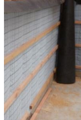
Vide technique derrière une finition en plaque de plâtre cartonné
