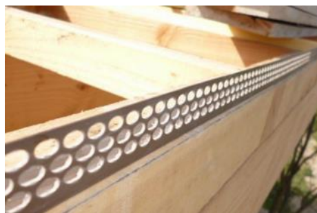
Grille anti-rongeurs (toiture végétalisée)
