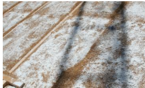
Saupoudrage de chaux aérienne sur la balle
