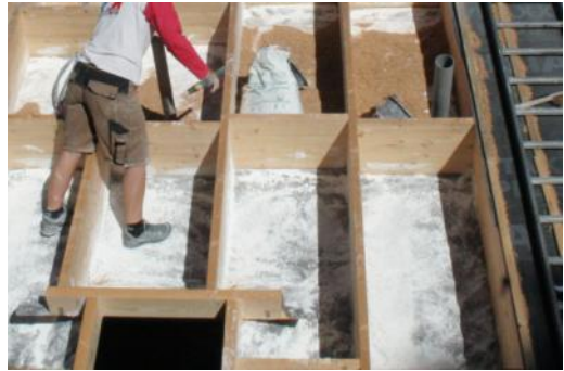
Saupoudrage de chaux aérienne en fond de caisson de toiture
