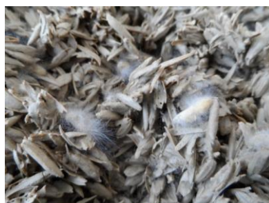
Fermentation autour de brisures de grains de riz dans un béton allégé
